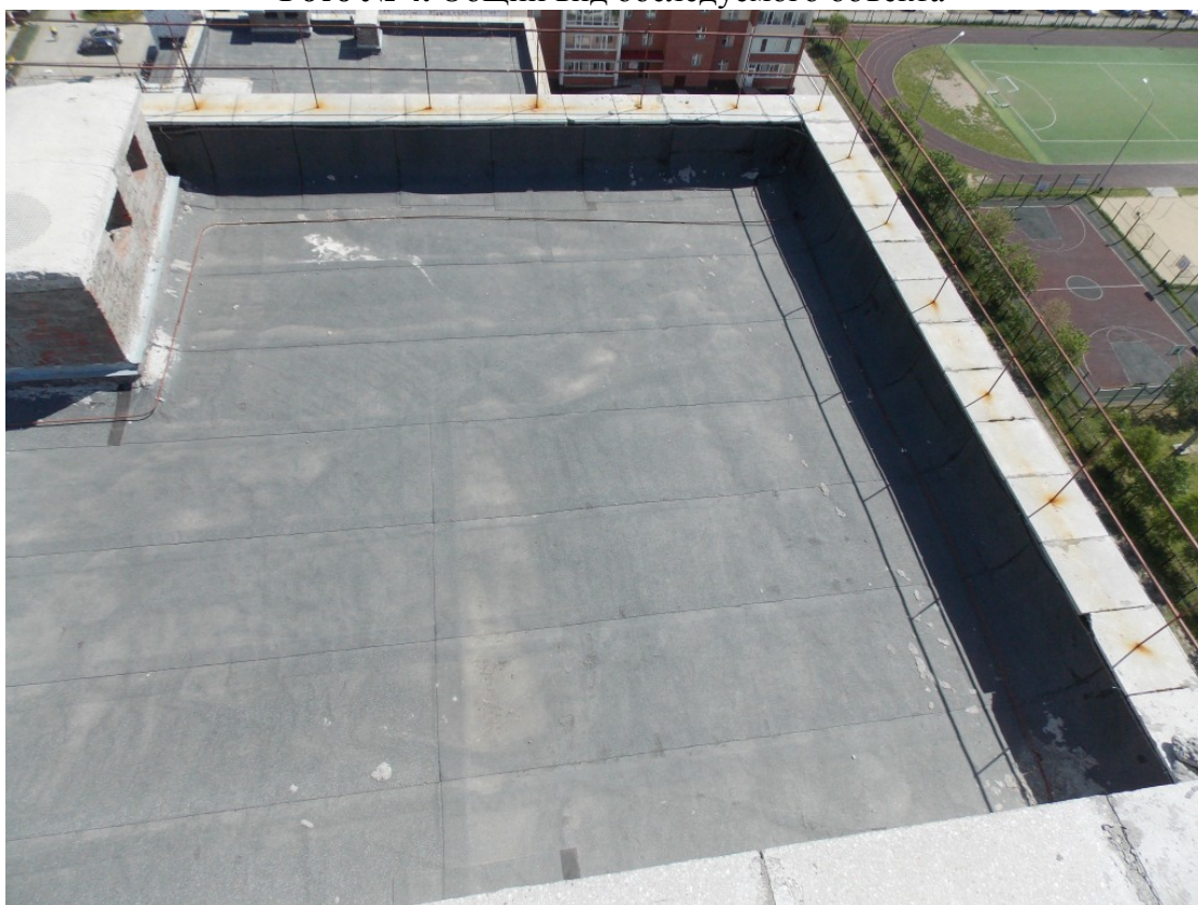
Фото № 4. Общий вид обследуемого объекта
