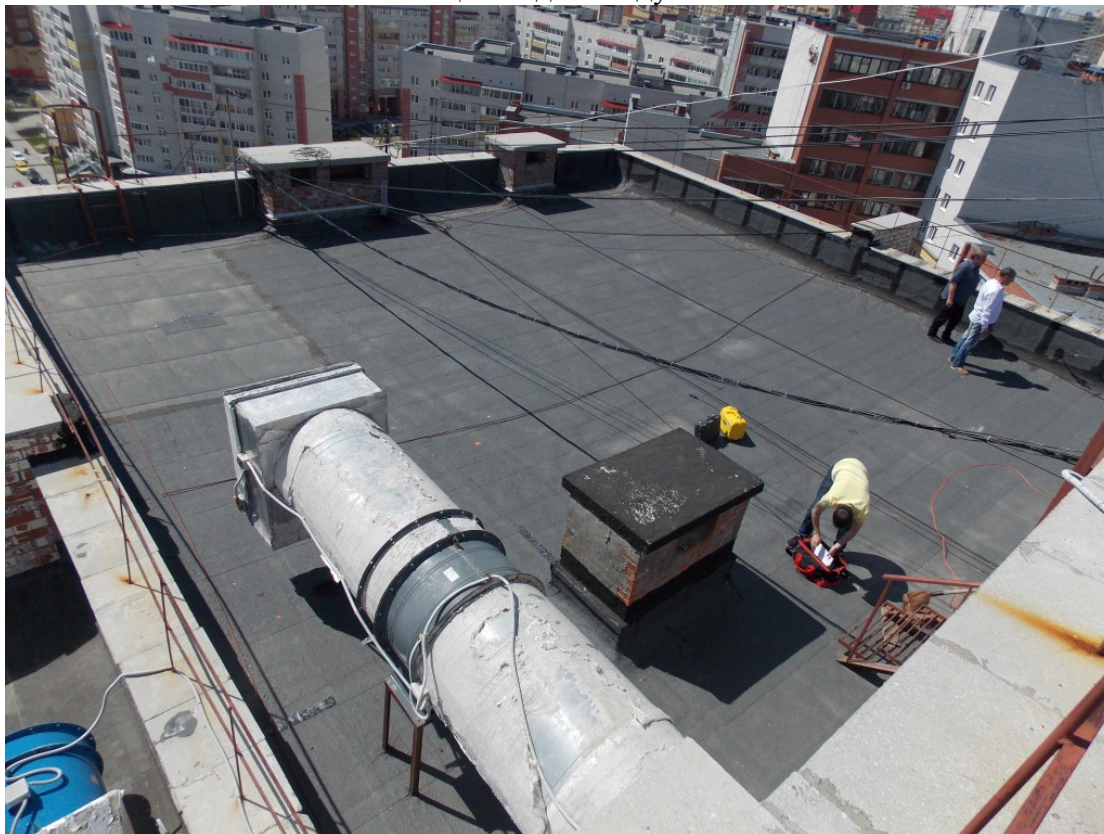
Фото №3 Общий вид обследуемого объекта
