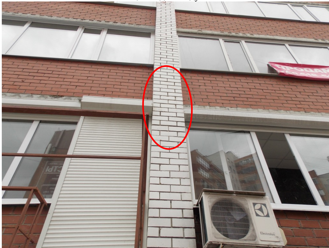
Фото №3 Общий вид обследуемого объекта
