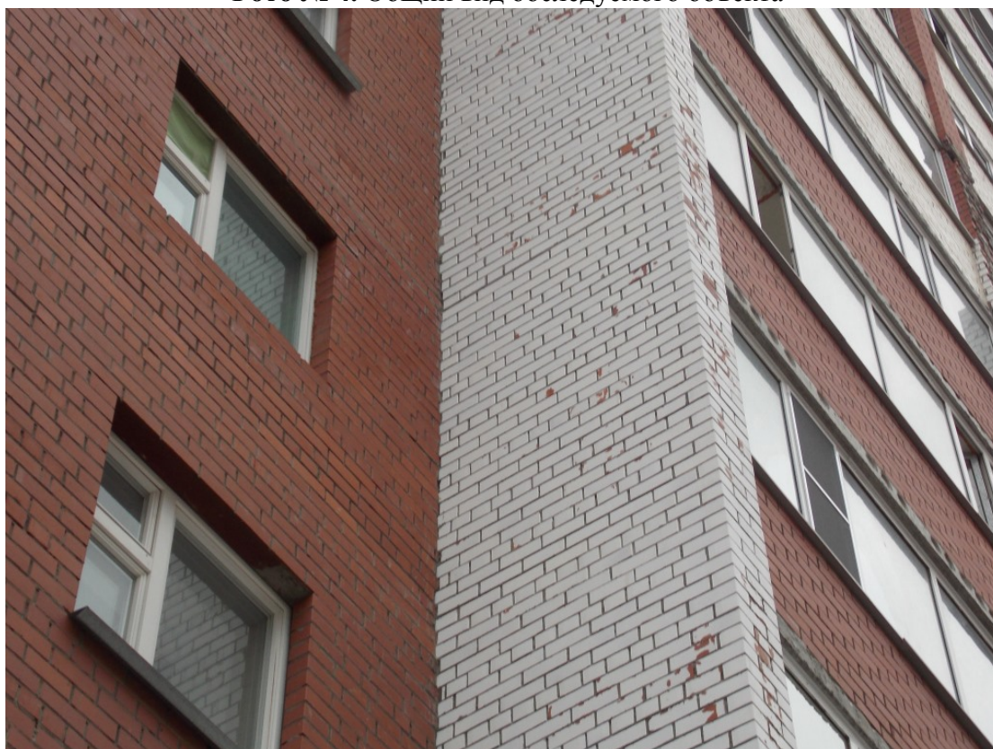
Фото № 4. Общий вид обследуемого объекта
